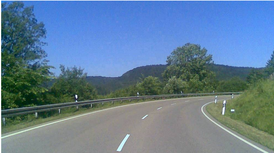
Lochenpass östlicher Teil - noch ohne Unterfahrschutz
