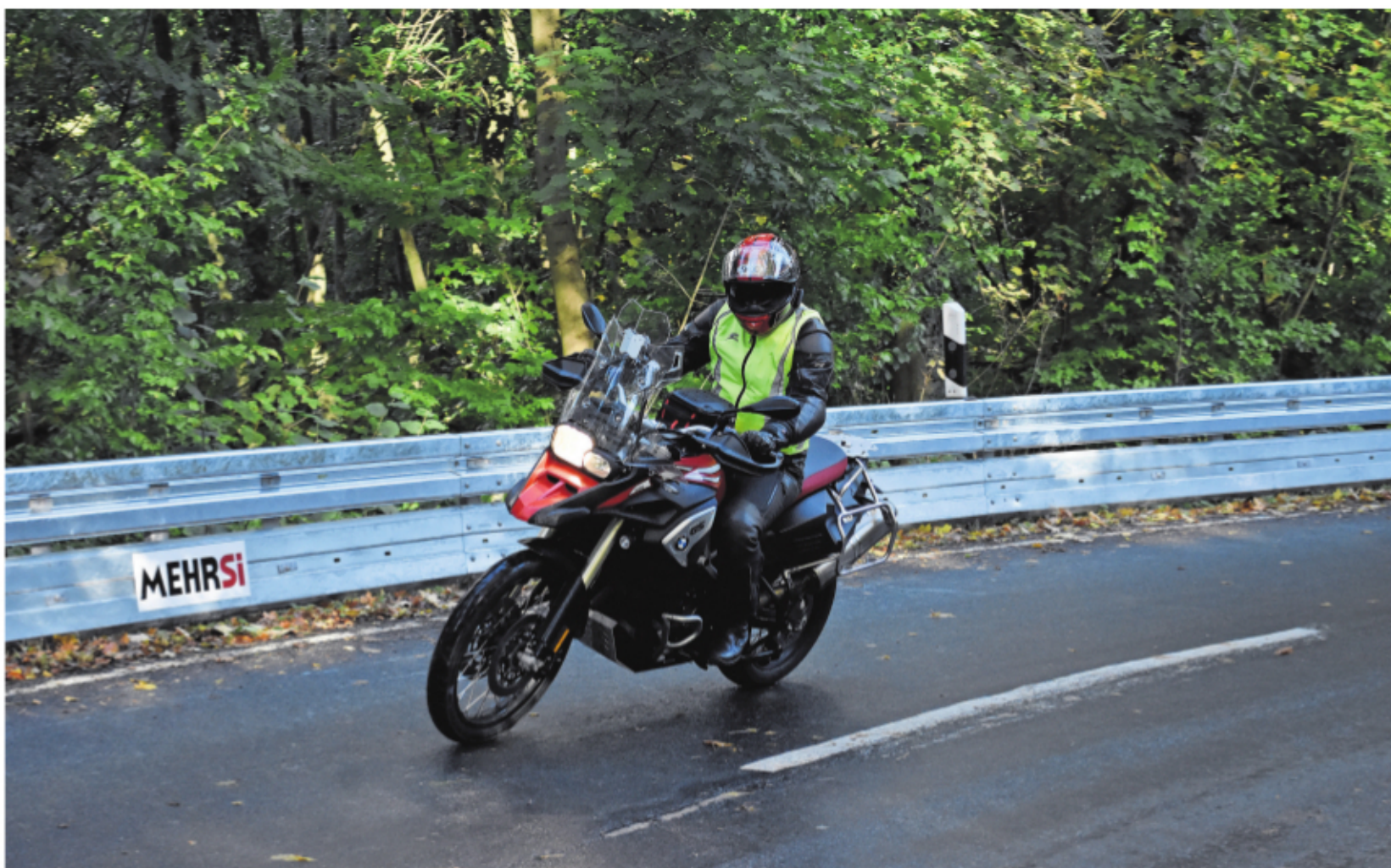
Motorradfahrer Tobias Nolte fährt die Kreisstraße am Marienberg mit einem besseren Gefühl entlang – dort gibt es nun einen Unterfahrschutz. FOTOS: MARK BODE
