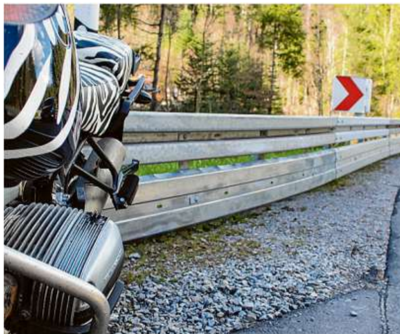
Sorgt für mehr Sicherheit: Eine federnde „zweite Schutzplanke“, die unterhalb der eigentlichen Planke angebracht wird.
