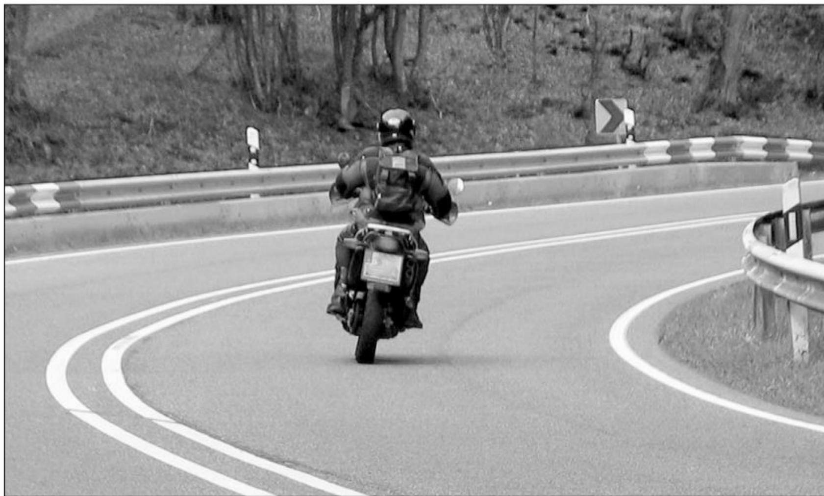
■ Mehr Sicherheit für Motorradfahrer soll der neuartige Unterfahrschutz "Modell Euskirchen" bieten. 12,5 Kilometer dieser Stahlprofile wurden bislang in 90 Kurven im Kreis angebracht.
