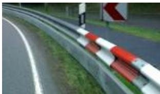
Leitplanke mit untergehängtem Unterfahrschutz
