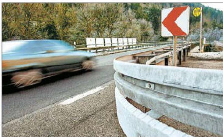
**Zusätzliche Metallplanken**, die bis zum Boden reichen, sollen an der Eisenbahnbrücke bei Birkenfeld verhindern, dass sich Motorradfahrer bei einem Sturz noch schwerer verletzen. Foto: Seibel
