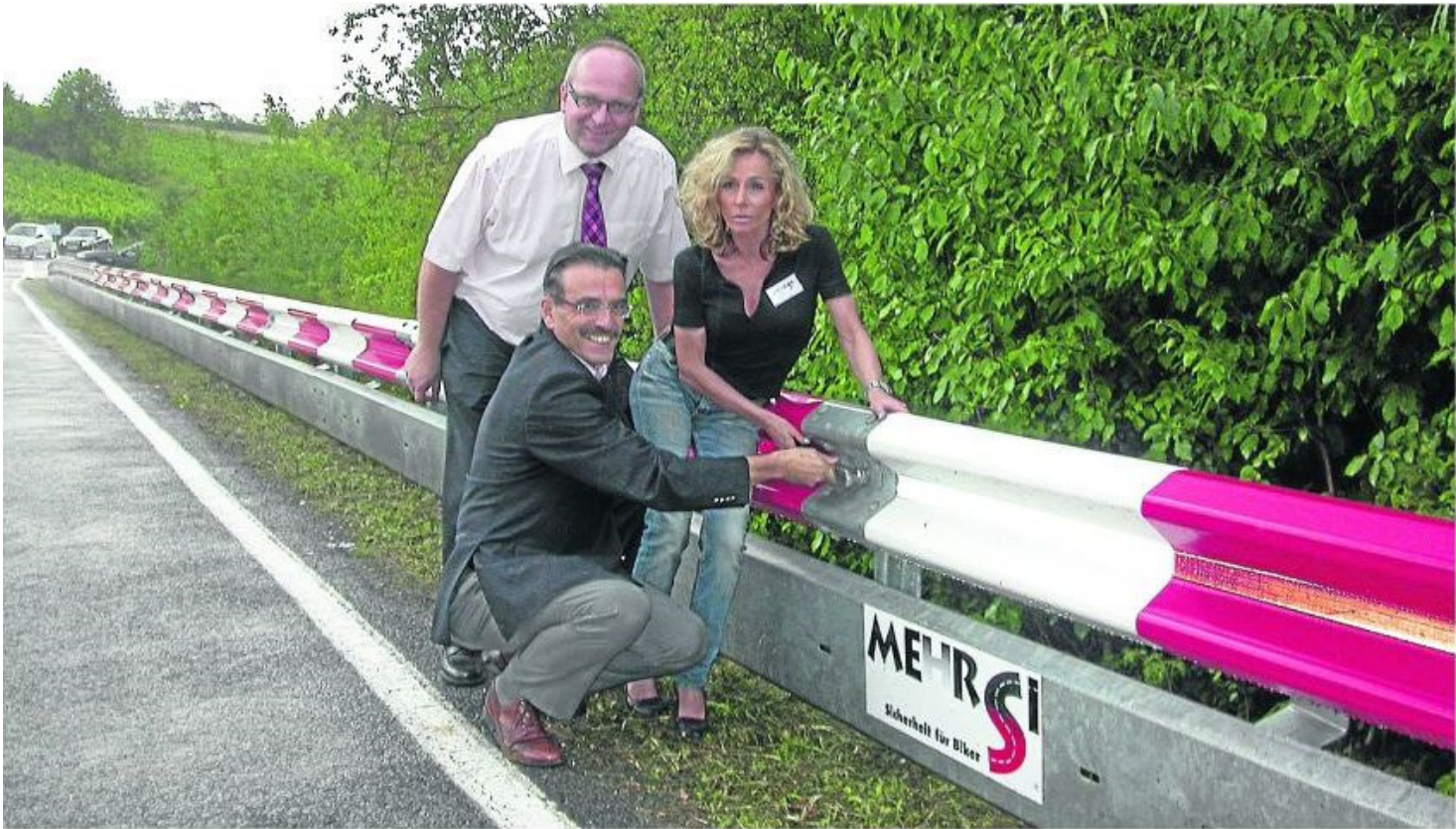
Den neuen Unterfahrschutz, den Monika Schwill erläuterte, sahen sich Landrat Franz-Josef Diel (Mitte) und der Leiter der Straßenmeisterei, Holger Conrad, an. Dadurch soll das Risiko stürzender Motorradfahrer minimiert werden, sich schwer zu verletzen.
