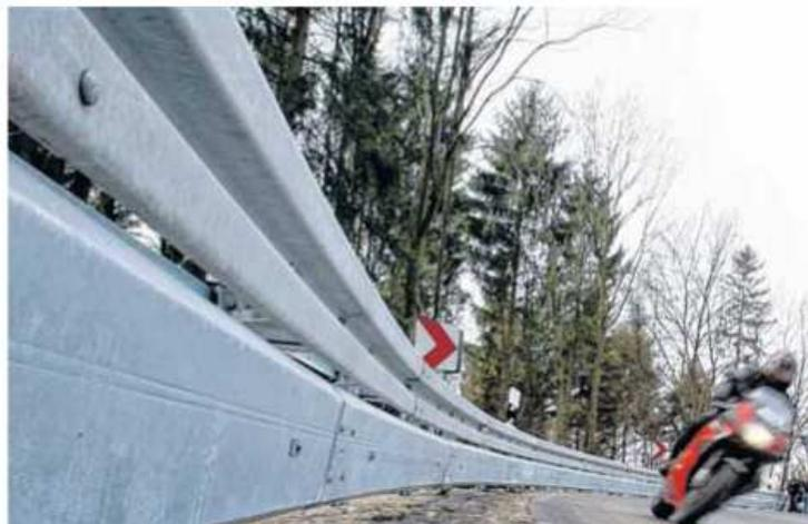
Der Unterfahrschutz soll verhindern, dass sich Motorradfahrer durch die Pfosten der Leitplanke schwer verletzen. Foto: dpa
